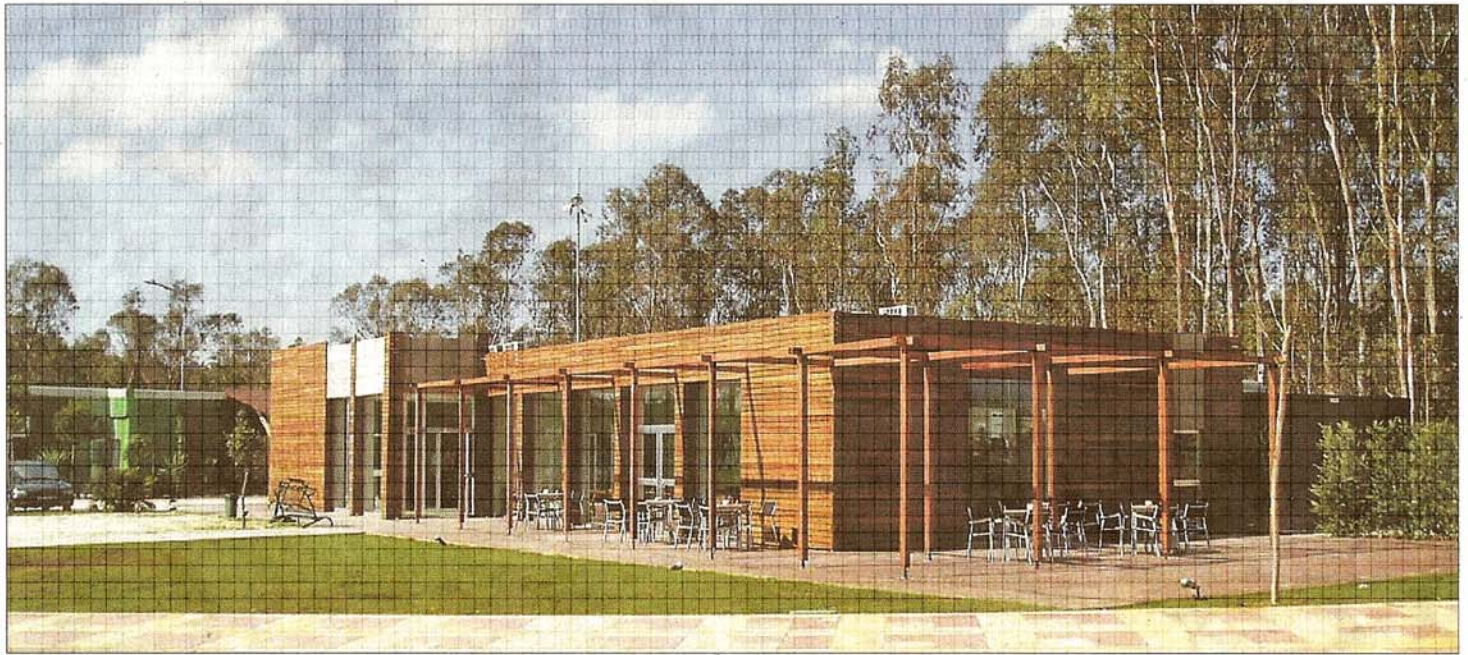
Casa Club en el Campo de Golf de Puerto Real (Cádiz), de 381 metros cuadrados, fabricado por Normetal en tres meses.
